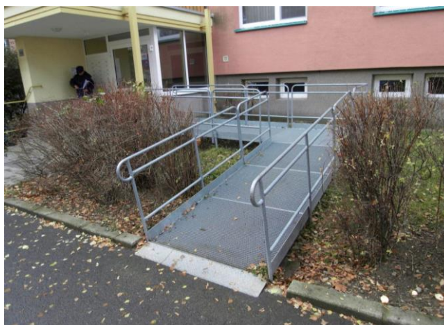
Príklad riešenia montovanej pravouhlej rampy
