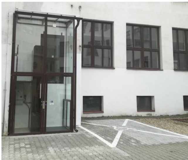
Príklad osadenia zvislej zdvíhacej plošiny v uzavretej presklenej konštrukcii (Rektorát STU v Bratislave)
