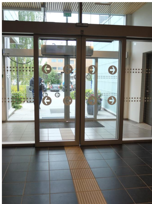
Označenie presklených vstupných dverí a umelá vodiaca línia na podlahe vo vstupných priestoroch (Univerzita NTNU, Gjøvik, Nórsko)
