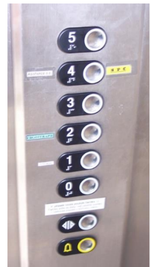
Riešenie ovládacích a privolávacích panelov výťahu s reliéfnym označením
