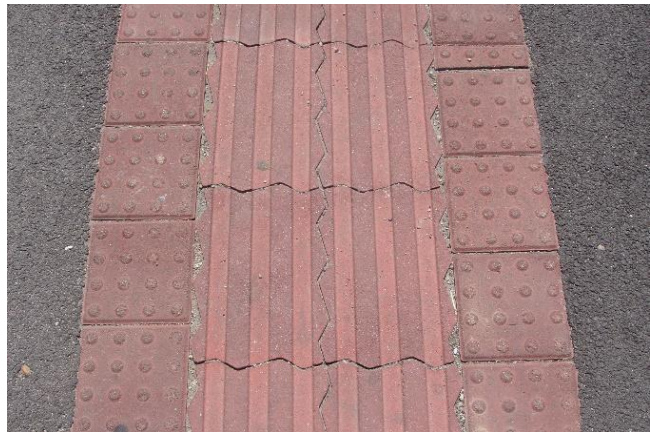
Signálny pás vo forme farebne kontrastnej reliéfnej dlažby s polguľovými výstupkami v kombinácii so žliabkovým profilom v strede
