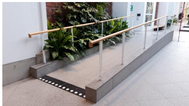
Príklady riešenia rampy s optimálnym sklonom 1:20 (Univerzita KI Štokholm)
