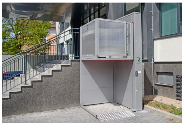
Príklad osadenia zvislej zdvíhacej plošiny pri vstupe
