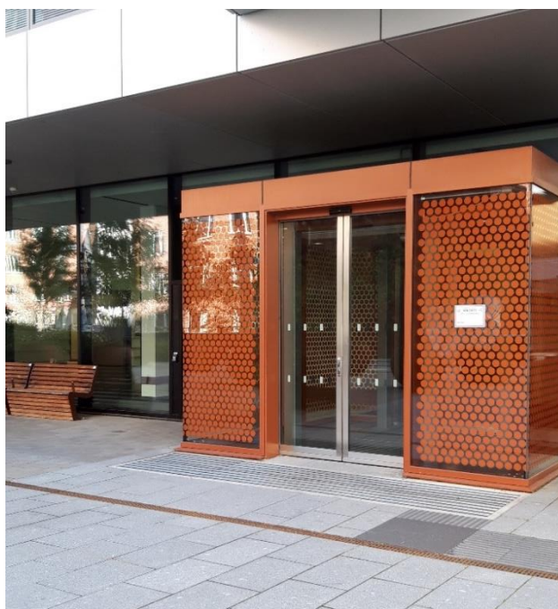
Označenie presklených vstupných dverí (KI, Štokholm)
