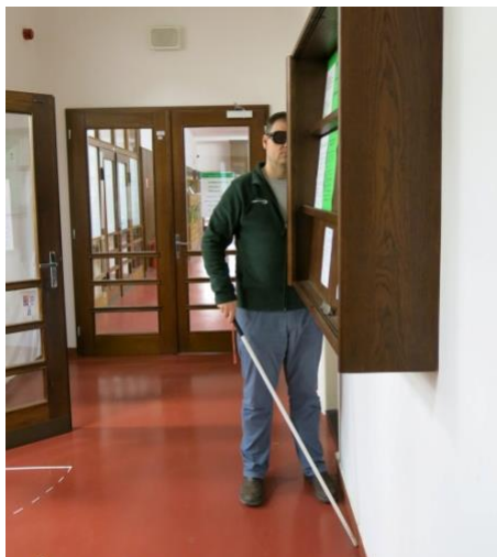
Nevhodné umiestnenie predmetov na stene (bez možnosti identifikácie v úrovni podlahy)
