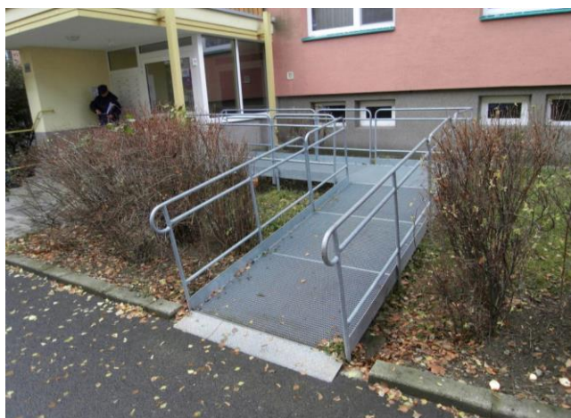
Príklad riešenia montovanej pravouhlej rampy
