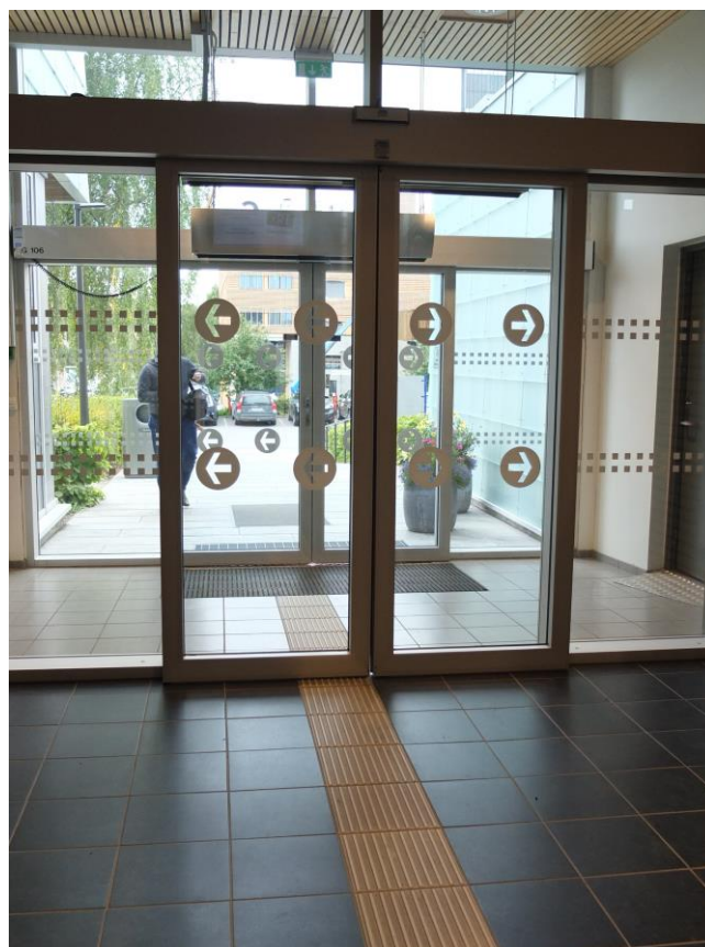
Označenie presklených vstupných dverí a umelá vodiaca línia na podlahe vo vstupných priestoroch (Univerzita NTNU, Gjøvik, Nórsko)
