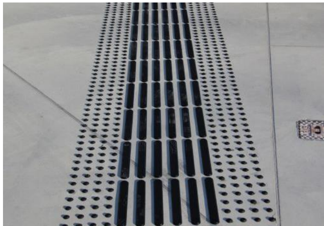
Signálny pás z hmatových indikátorov (polguľové a pozdĺžne výstupky) navádza ku vstupu do budovy https://www.olejarsafety.sk/referencie/kulturpark-kosice-slovensko2
