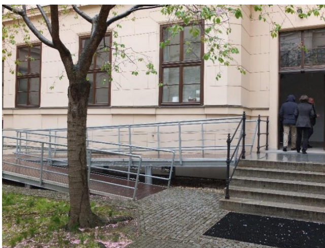
Príklad riešenia rampy (Masarykova univerzita v Brne)
