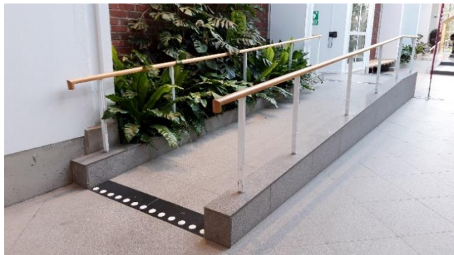
Príklady riešenia rampy s optimálnym sklonom 1:20 (Univerzita KI Štokholm)
