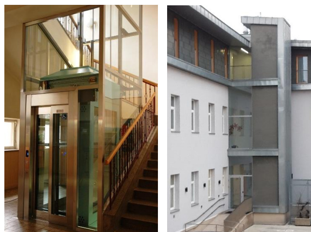
Príklady umiestnenia výťahu v zrkadle schodiska alebo v exteriéri na fasáde
