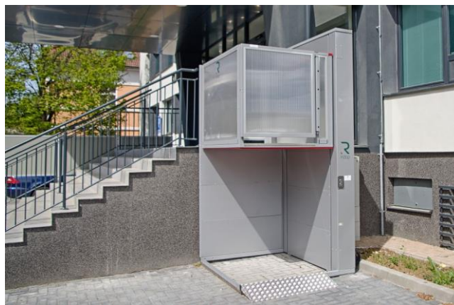
Príklad osadenia zvislej zdvíhacej plošiny pri vstupe
