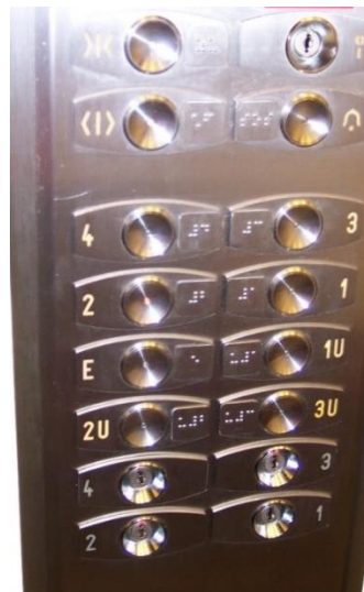
Riešenie ovládacích a privolávacích panelov výťahu s reliéfnym označením
